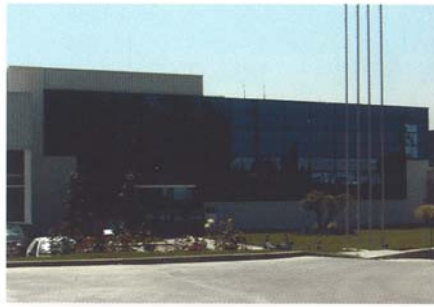
PROBITAS PHARMA (LABORATORIOS GRIFOLS) PARETS DEL VALLÈS (BARCELONA)
